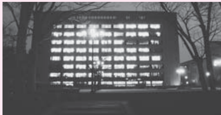
▶ 不夜城と化す津市役所本庁舎
