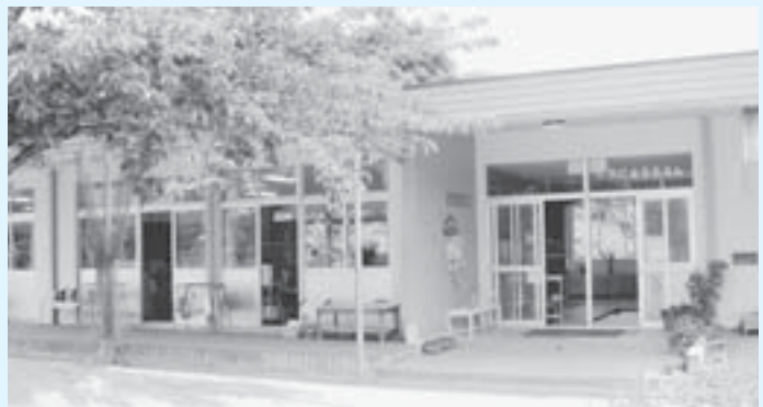
▶旧建築基準法で建てられた公共建築物の耐震強化を(黒田幼稚園)
