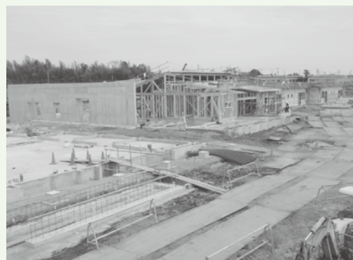
建設中の民間保育園
