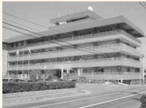
▶公共施設で一番地震で危ない久居庁舎
