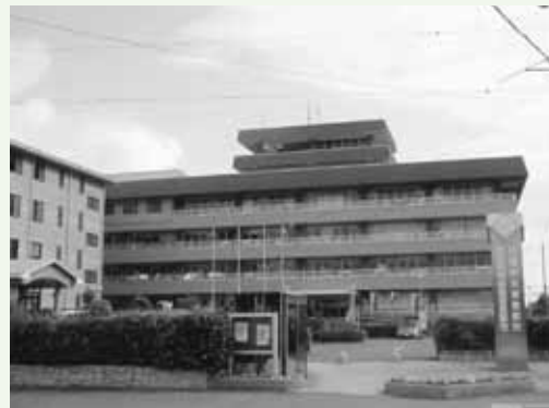
▶耐震性の低い久居庁舎の早期改修を
