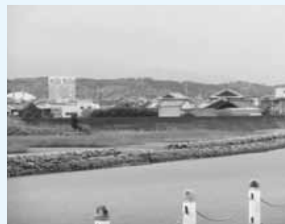
▲高台のない地域に避難タワーを（河芸地域の海岸堤防）
