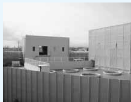
▲平成30年使用開始に向け、工事が進む浄化センター
