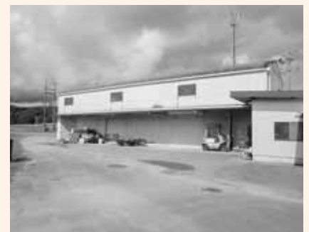
▲人・農地プランの核となる集落営農組織の機械格納庫施設
