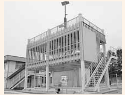
▲津波避難タワー（製造メーカーのホームページより）
