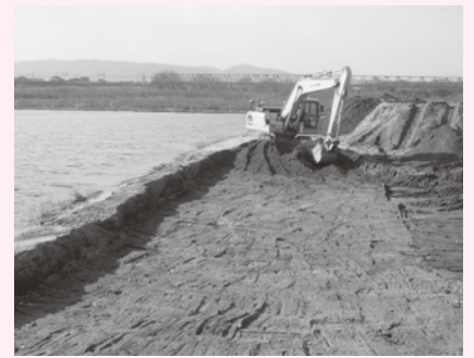
▲浸水被害を未然に防ぐ、河川しゅんせつ事業の様子
