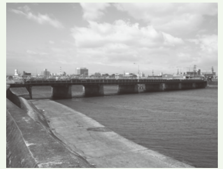
▲国の交付金を活用し、橋梁等インフラの老朽化対策推進を
