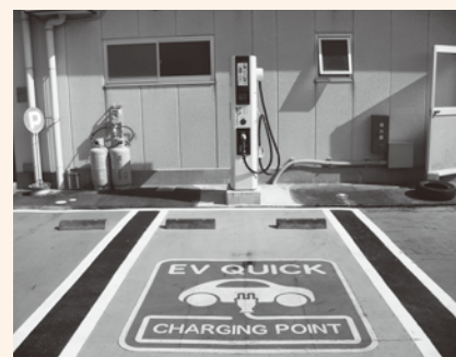
▲手軽に急速充電が可能なEVステーション
