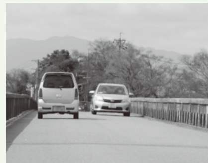
▲大型車が通行すると危険で狭い香良洲橋
