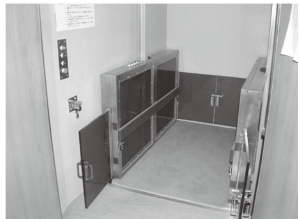
◀ 車いす用リフト
