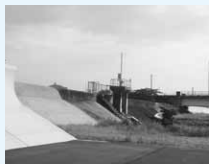
▲今年度かさ上げ工事が着工予定となった雲出古川右岸堤防
