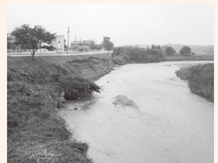
▲災害復旧を急ぐとともに土砂撤去等、河川の抜本的改修を
