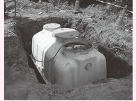
▲生活環境の保全等を図るため市営浄化槽事業の推進を
