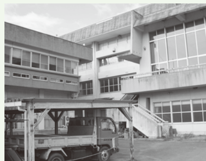
▲老朽化し使用しなくなった公共施設
