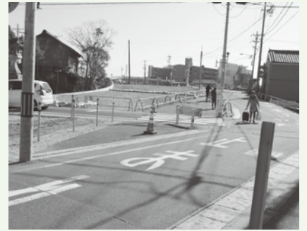
▲完了した安全対応策 (江戸橋西詰)
