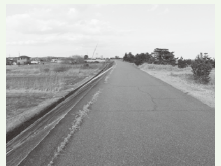
▲高さ不足から早期整備が待たれる白塚漁港海岸の堤防
