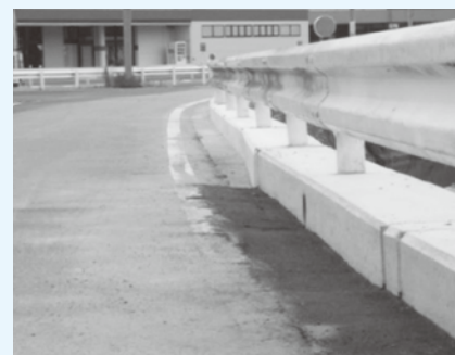
▲一志地域の懸案、井関地内波瀬川左岸かさ上げ工事完了
