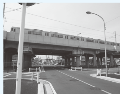
▲鉄道高架化によって危険踏切の解消を（愛知県提供）
