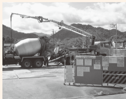
▲工事が進められている一志消防分署
