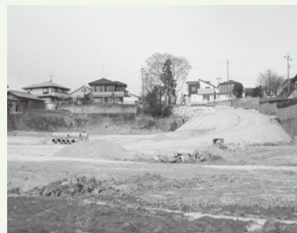
▲すでに進められている観音寺町地内の開発工事
