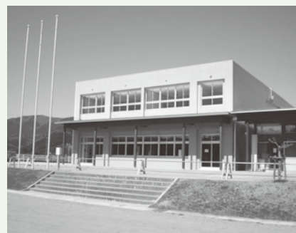
▲着々と工事が進む義務教育学校みさとの丘学園
