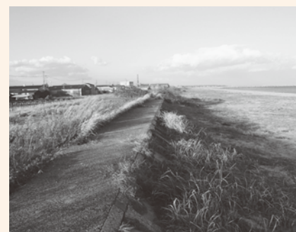
▲早期整備が熱望されている津北部地域の海岸堤防
