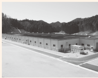
▲第1期工事完成時の津市一般廃棄物最終処分場
