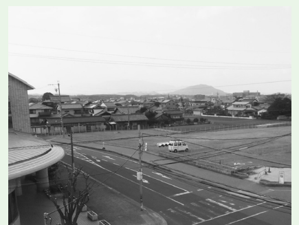
▲準備が進む(仮称)津市久居ホールの建設予定地
