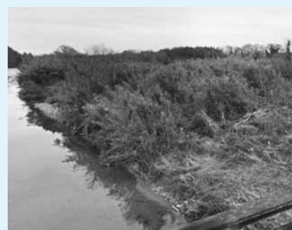
▲樹木が繁茂し、土が堆積している中川原橋下流付近
