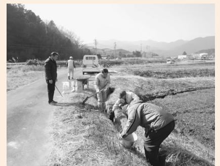
▲地域住民の共同作業による水路の目地補修
