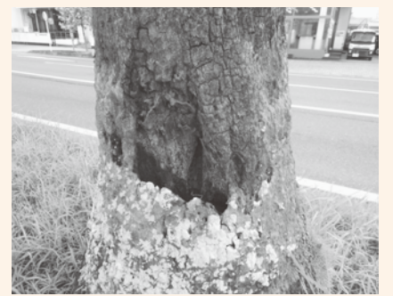
▲ 幹の一部が腐食し、倒木が心配されるフェニックス
