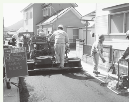
▲進められている公共下水道整備
