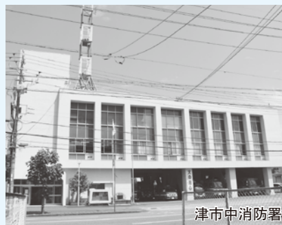
▲老朽化している津市中消防署と同西分署の整備促進を
