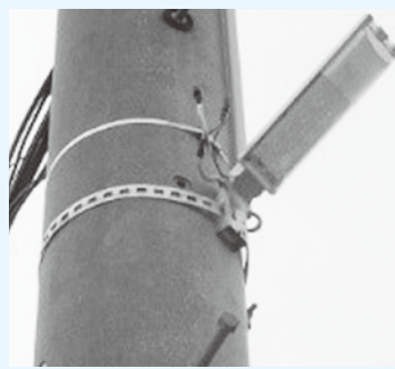
▲防犯灯設置補助金の見直しを
