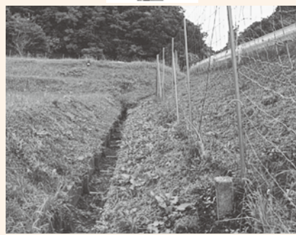
▲農家等の奉仕作業による市道のり面の草刈状況
