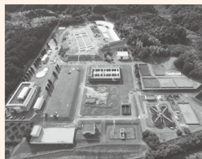
▲長良川からの県営水道が通る大里浄水場
