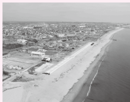
▲国直轄事業として改修が進む栗真工区の海岸堤防
