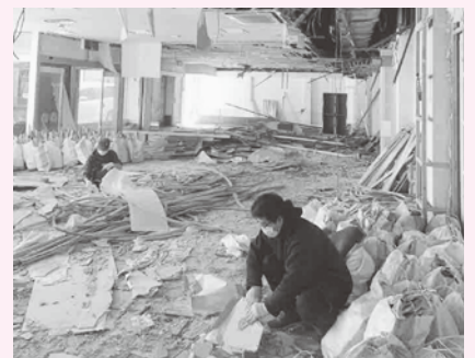
▲出店者自らが店舗改装を行うセルフリノベーション
