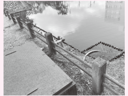
▲津市の合併前から止まっているお城公園のポンプ設備
