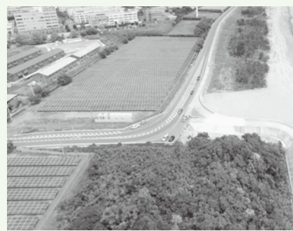
▲整備が進む河芸町島崎町線
