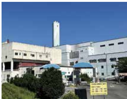
津市西部クリーンセンター焼却施設
