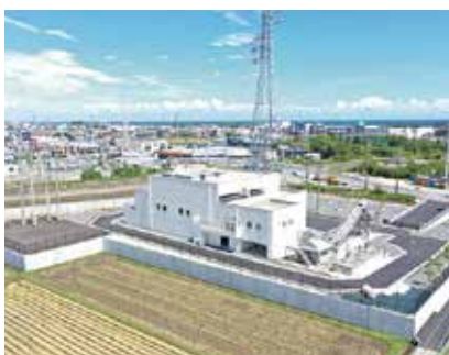
津市天神ポンプ場
